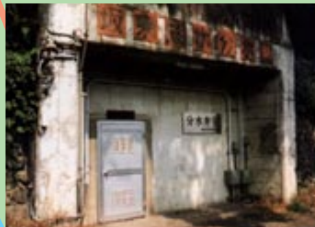
群馬県企業局坂東用水分水室（北橋村）
