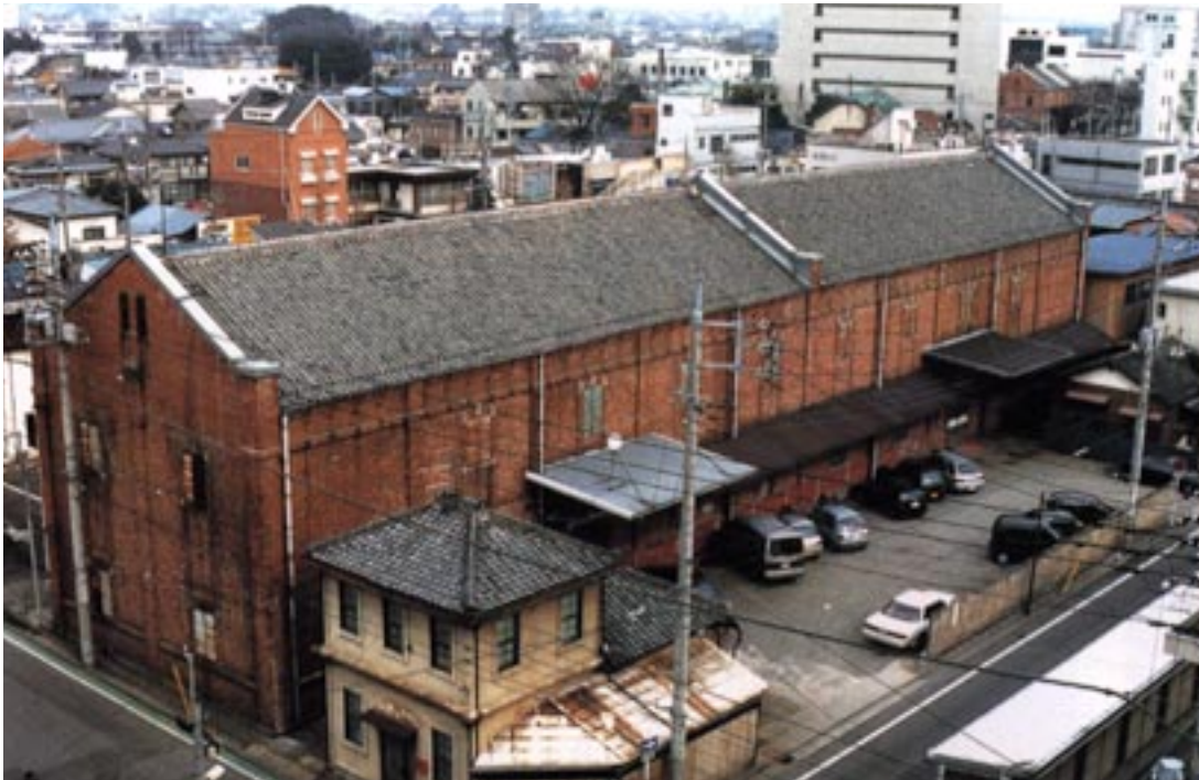
前橋市住吉町1-10-2 明治43年（1910）竣工 煉瓦造2階建 瓦葺屋根
