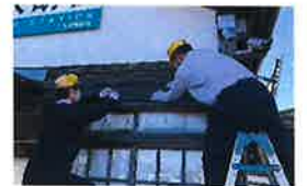
飾り付け作業
